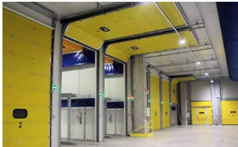
Il sistema brevettato FIDELITY® di apertura idraulica dei portoni migliora nettamente la tenuta perimetrale rispetto ai sistemi bilanciati a molle dato che, in chiusura, il portone sigilla a terra con tutto il suo peso per semplice gravità. Il sistema FIDELITY® elimina, inoltre, il periodico ricarico delle molle di bilanciamento che non esistono più ed evita la caduta di residui metallici e/o ossido derivanti dallo sfregamento delle spire delle molle.
