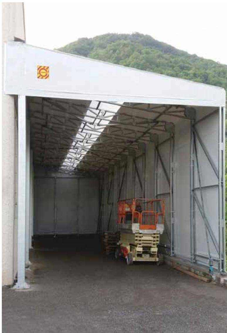
*Struttura montata su una trave in carpenteria sostenuta da una serie di colonne con interasse dai 5 ai 6 metri, questa copertura viene realizzata con un **tetto mono falda**.*
