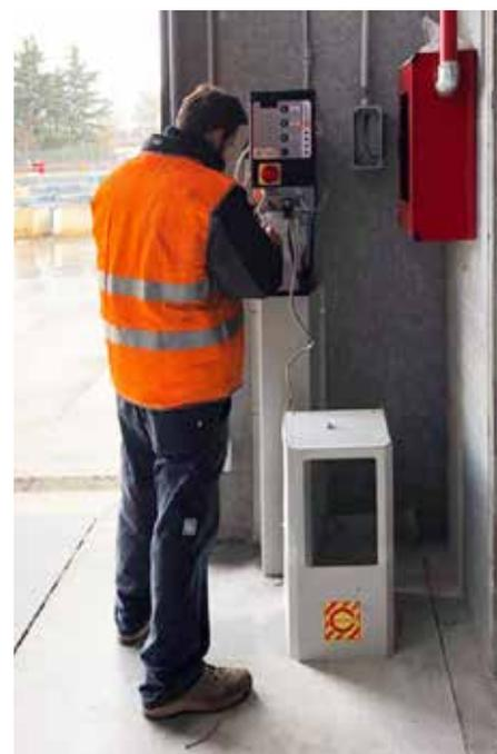
L'ispezione di routine si riduce al semplice controllo del livello dell'olio all'interno della CONSOLLE posta a parete ad altezza uomo.
