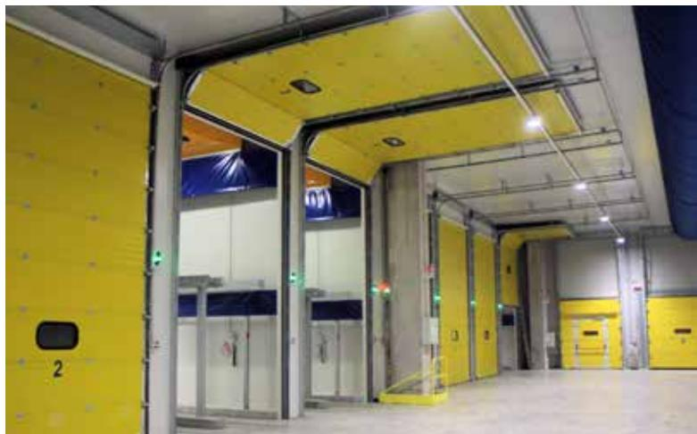
Il sistema brevettato FIDELITY® di apertura idraulica dei portoni migliora nettamente la tenuta perimetrale rispetto ai sistemi bilanciati a molle dato che, in chiusura, il portone sigilla a terra con tutto il suo peso per semplice gravità. Il sistema FIDELITY® elimina, inoltre, il periodico ricarico delle molle di bilanciamento che non esistono più ed evita la caduta di residui metallici e/o ossido derivanti dallo sfregamento delle spire delle molle.
