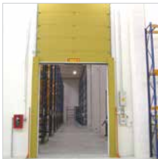
Tagliafuoco apertura verticale per uso intensivo EN 1634-1
