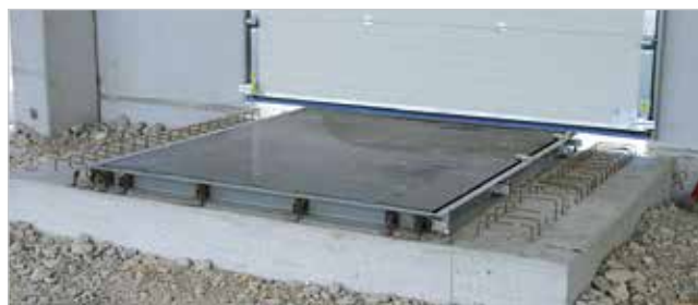
Rampa SOSPESA "C" prima del pavimento
