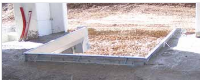
Banchina Prefabbricata cementata a meno 20 cm, senza la dima, pronta per la gettata del pavimento
