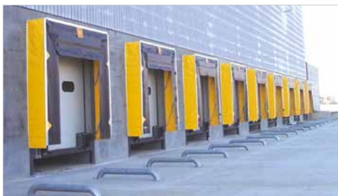
Baie Recessa con sigillanti retrattili per "freschi" tra 0°C e + 5°C
