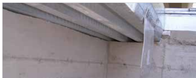
Particolare della lamiera grecata ad aderenza migliorata per la costruzione degli aggetti
